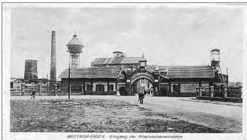
BOTTROP-EIGEN. Eingang der Rheinbänschächte
