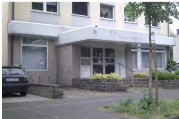
Trostlos - das einzige lebendige an der ehemaligen Sparkassenfiliale in Welheim ist der Baum davor
