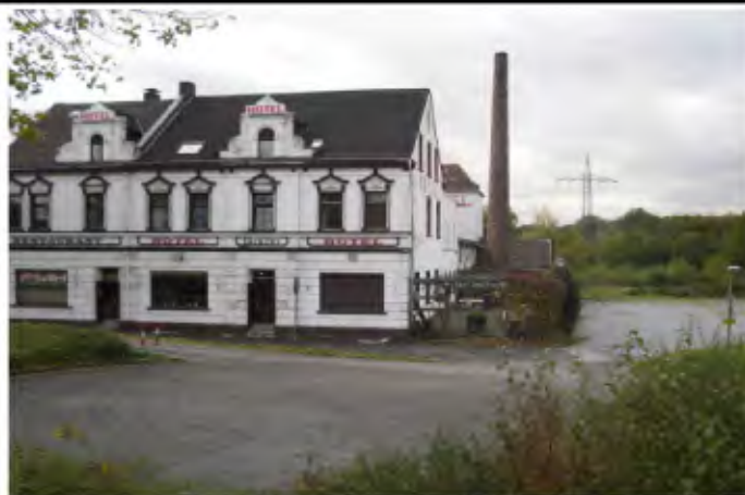
Das ehemalige Hotel Sackers mit Brennerei soll bald Procar weichen
