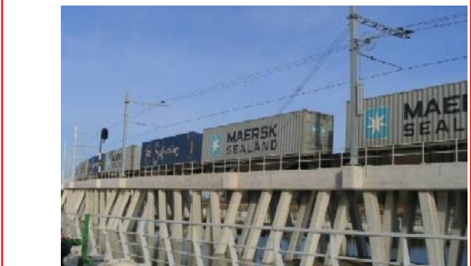
Eine Alternative für den überhand nehmenden Schwerlastverkehr ist seit jeher der Transport auf Schienen und Wasserstraßen.
